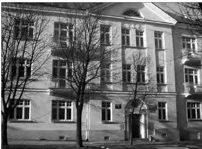
Budynek Instytutu Edukacji Muzycznej przy ulicy Mickiewicza 3
